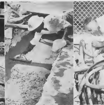
UN SISTEMA di grounding ta instalá door di trahadornan, ariba robes. Otro nan ta parabá e concreto basha promer cu e sanja ta yena, ta solda e cablenan cu ta hasi pa e sistema di grounding di e substation di gobiernu, y ta traha casita door di cual Lago su cable di corriente lo warda conecta na e equipo di switch di gobiernu.
